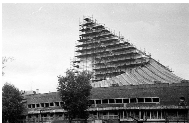
Рисунок 5. Строительство ТЮЗа. Фото 1978 г.
