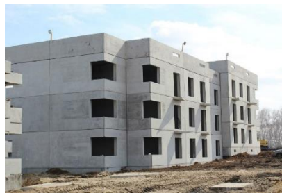
Рисунок 11. Панельное строительство 6
