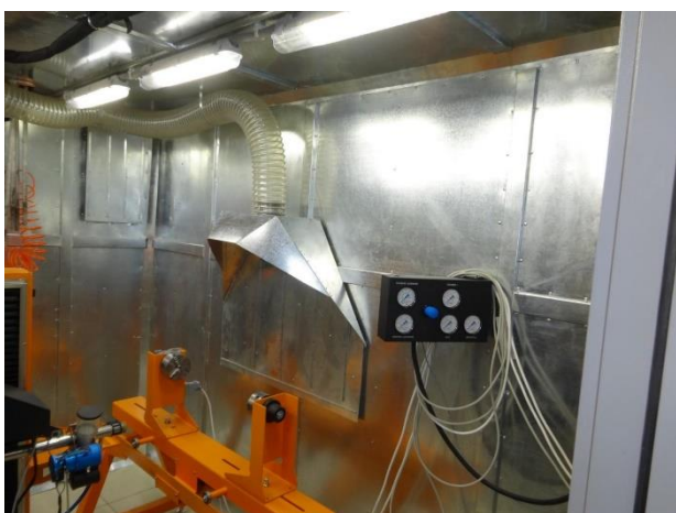
Рисунок 4. Установка для напыления с зонтом локальной вентиляции
