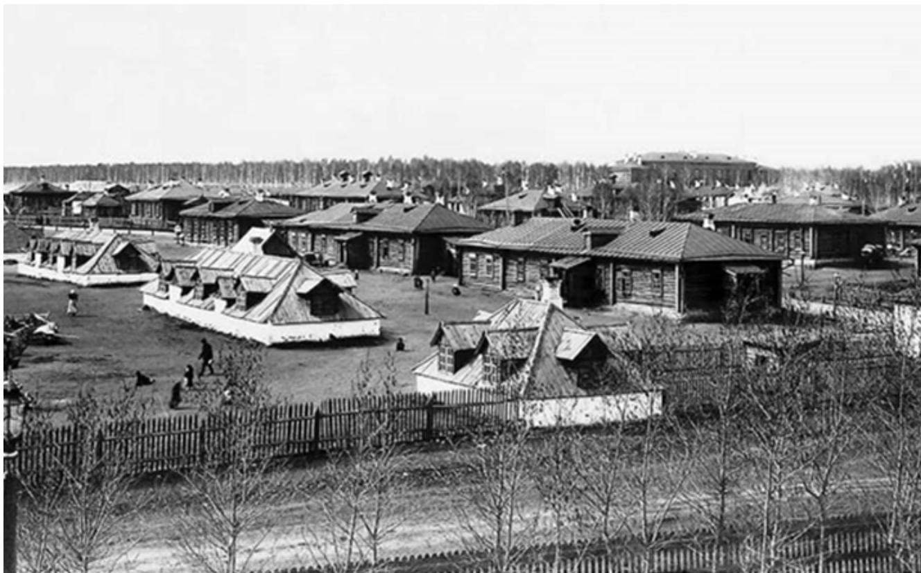
Илл. 5. Общий вид Челябинского переселенческого пункта.
