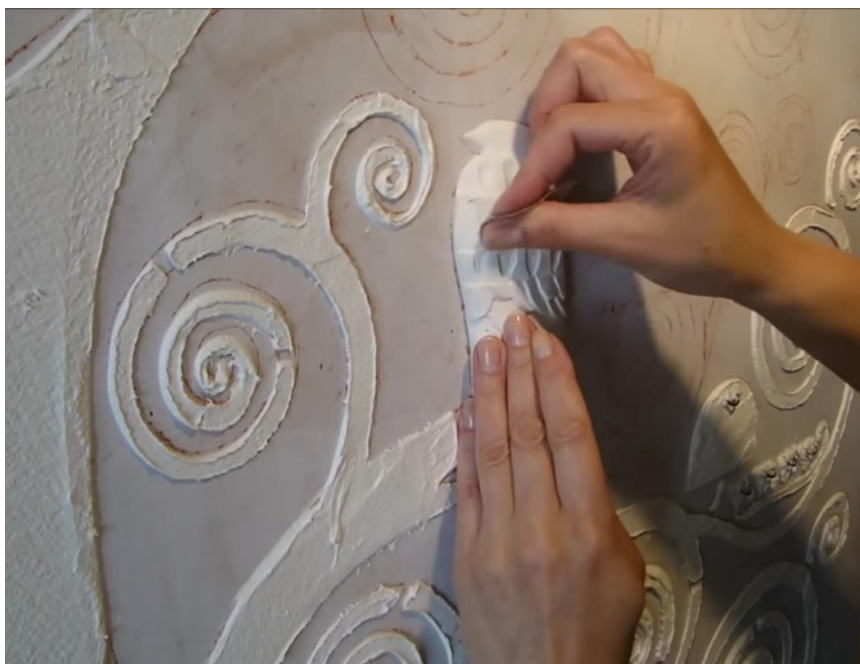
Рис. 5. Ошкуривание мелкозернистой наждачной бумагой
