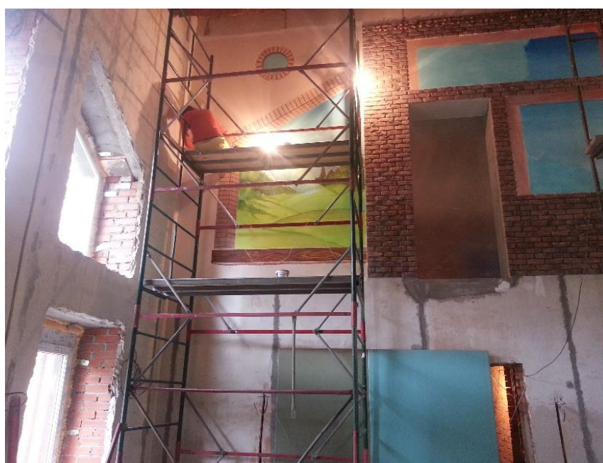
Рис. 4. Установка лесов. Начало росписи
