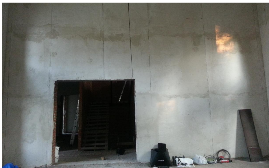
Рис. 1. Стена перед началом художественных работ
